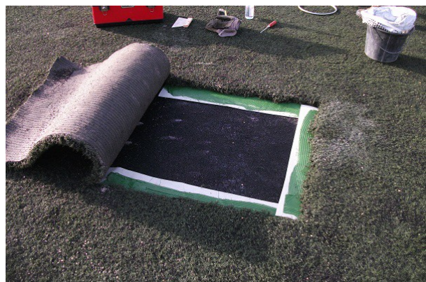
Bandes de collage avant remise en place du gazon.
