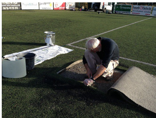
Remise en place de la GNT, du géosynthétique,
