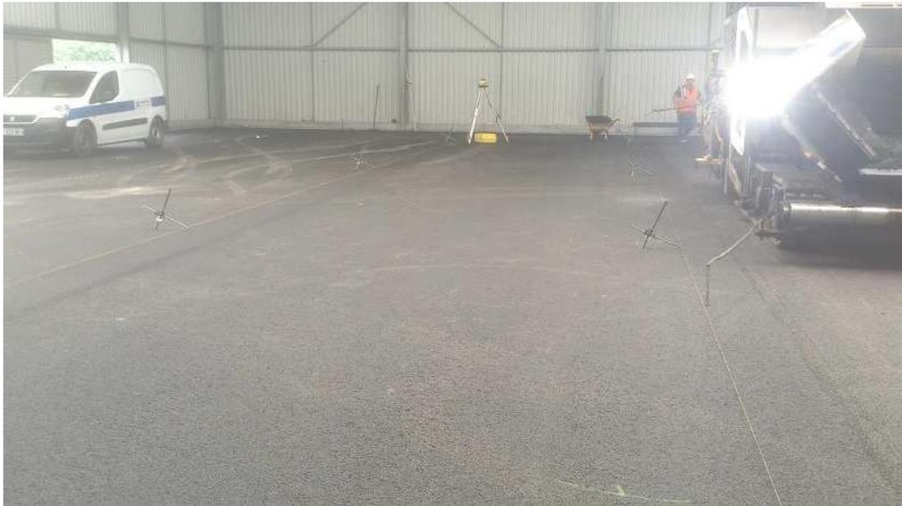
2ème couche BB 06 fiches cordeaux mis en place au laser, le niveau fini sur les murs est tracé au cordex
