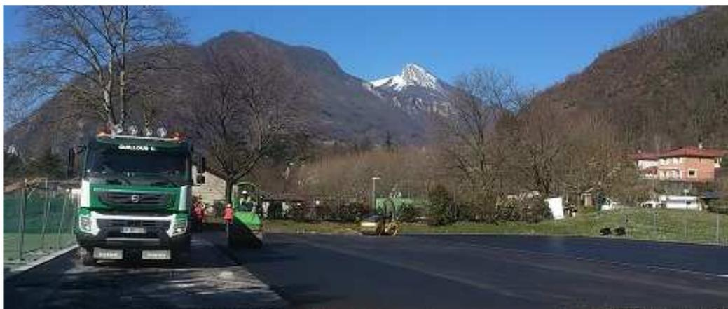
2ème couche BB 0/6 palpeur sur bande réalisée + palpeur sur bordure
